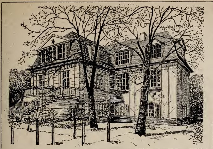
Abb. 83. Haus mit gebrochenem Dach
