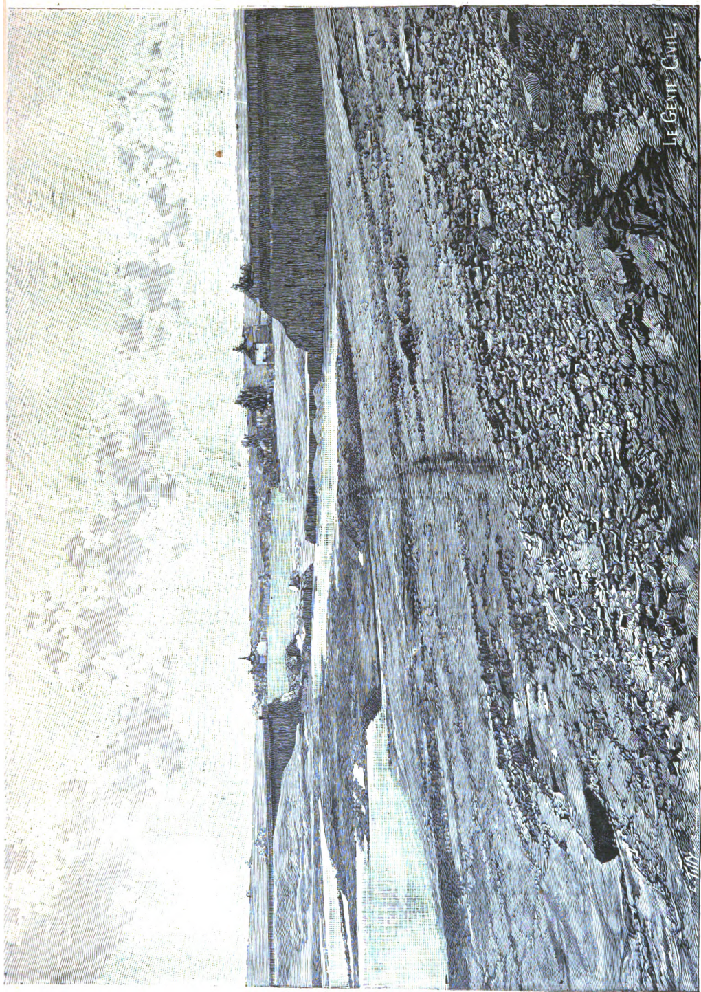
Fig. 104. — Vue d'amont du barrage de Bouzey après sa rupture.
